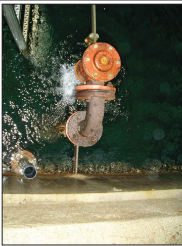
Alimentation par robinet flotteur de la cuve de droite
