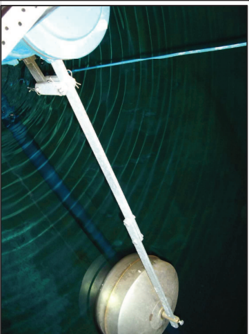
Robinet flotteur cuve 1
