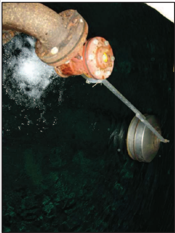
Alimentation par robinet flotteur
