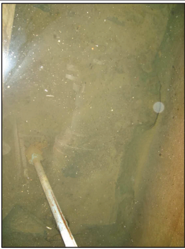
Alimentation par robinet flotteur de la cuve de droite
