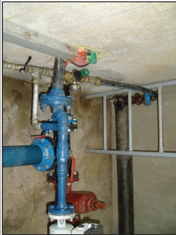
Accès chambre de vannes et by pass
