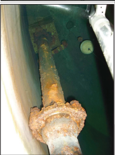
Trop plein et flotteur de la cuve de droite
