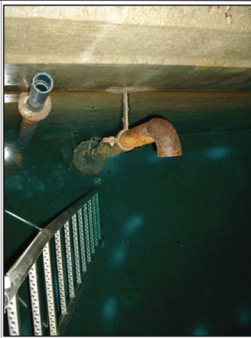
Alimentation fermée de la cuve de gauche
